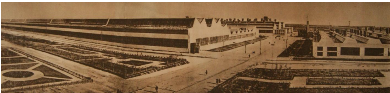
Ил. 1. Панорамный вид на корпуса Челябинского тракторного завода, фото 1933 года [3].
