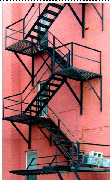
Ил. 2. Образец пожарной лестницы на фасаде здания
